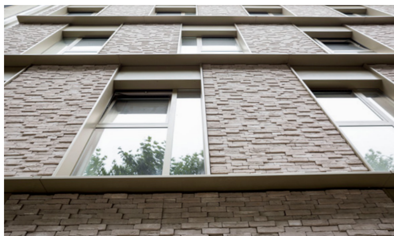
Circulaire paneelsysteem Studentenhuisvesting Franklin Rooseveltplaats
